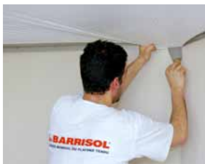
Installation d'un plafond Barrisol®
