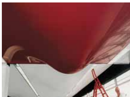
Réparation d'un plafond Barrisol® suite à un dégât des eaux.
